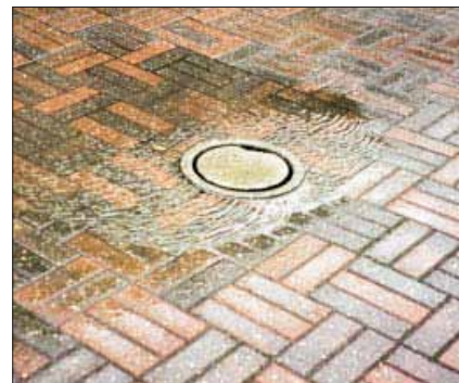
Lunker der giver vandsamlinger skal rettes op.
